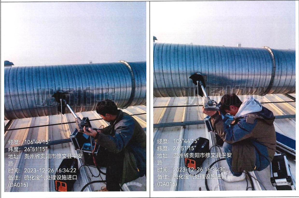
有组织废气现场监测图片
