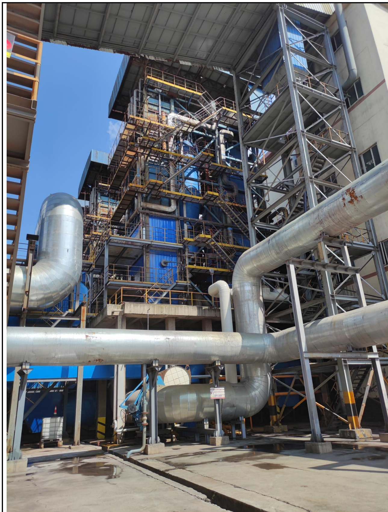
图 2-1 已改造锅炉
