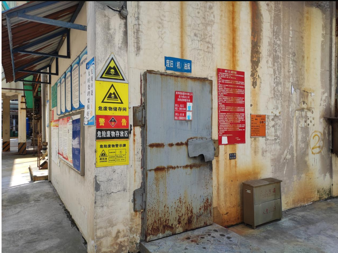
图 4.2-6 危险废物警示牌上墙
