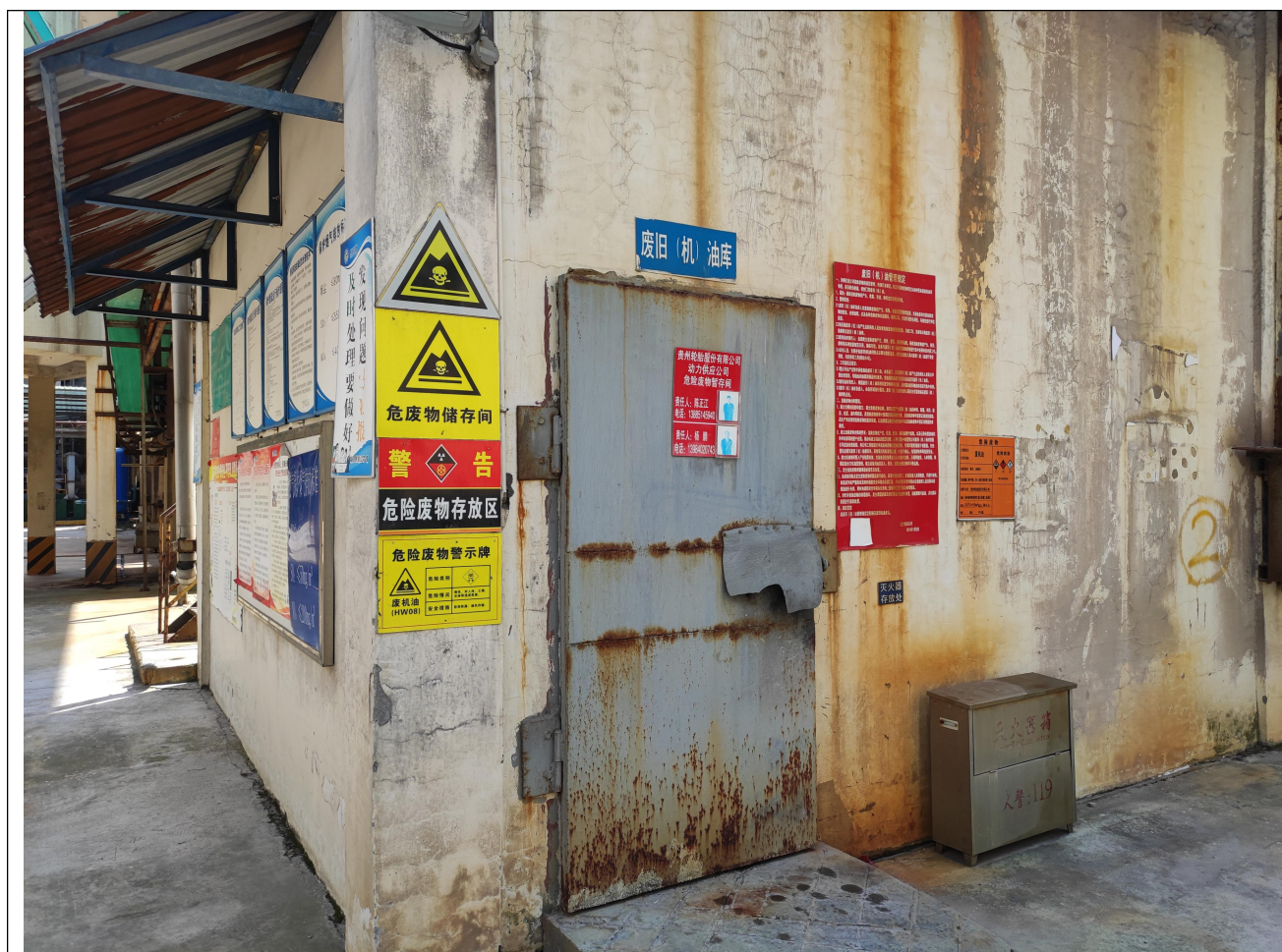
图 7-1 危废暂存间标识
