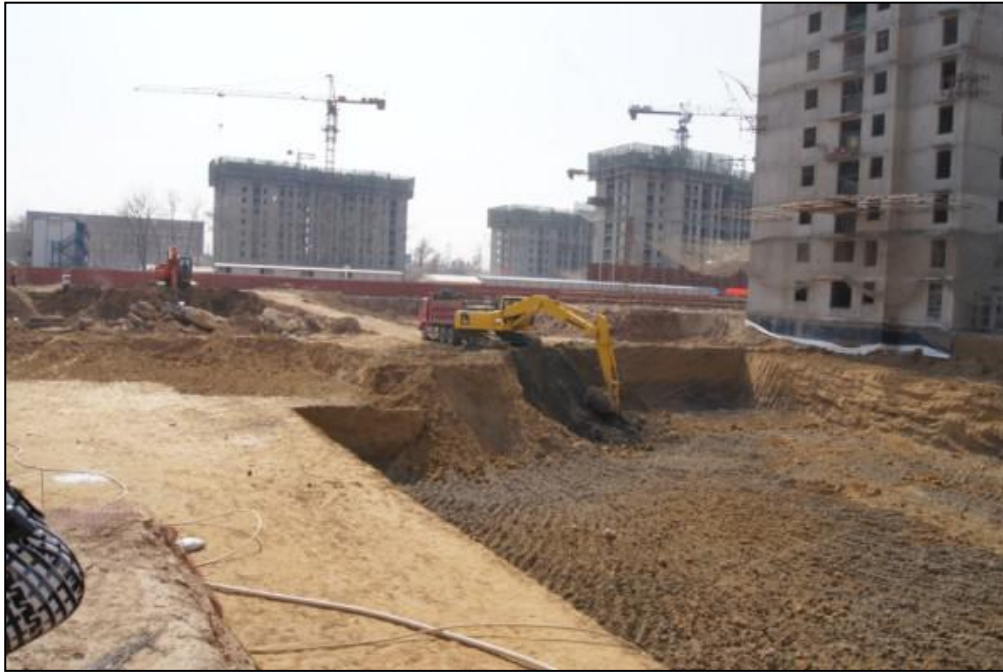
图 7-8 分层开挖照片
