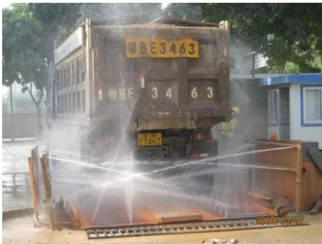
图 11-2 土方车清洗照片
