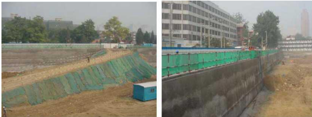
图 13-2 坡道防护和基坑临边防护照片示例
